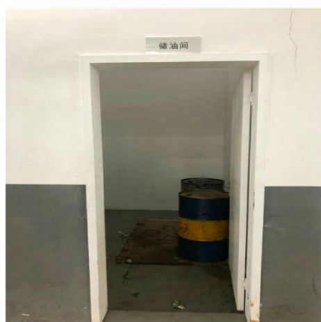
图 10 废机油存放装置
