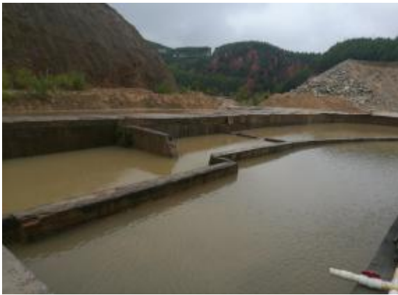
一号场沉淀池
