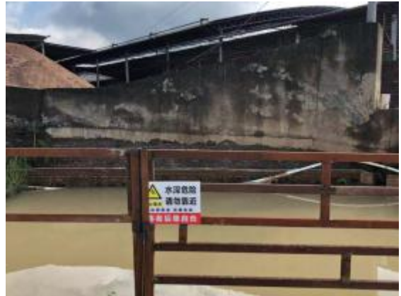
沉淀池警示牌
