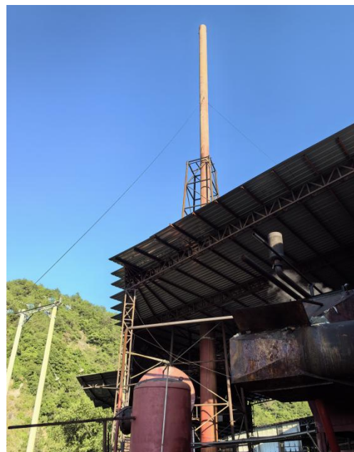
锅炉废气排气筒
